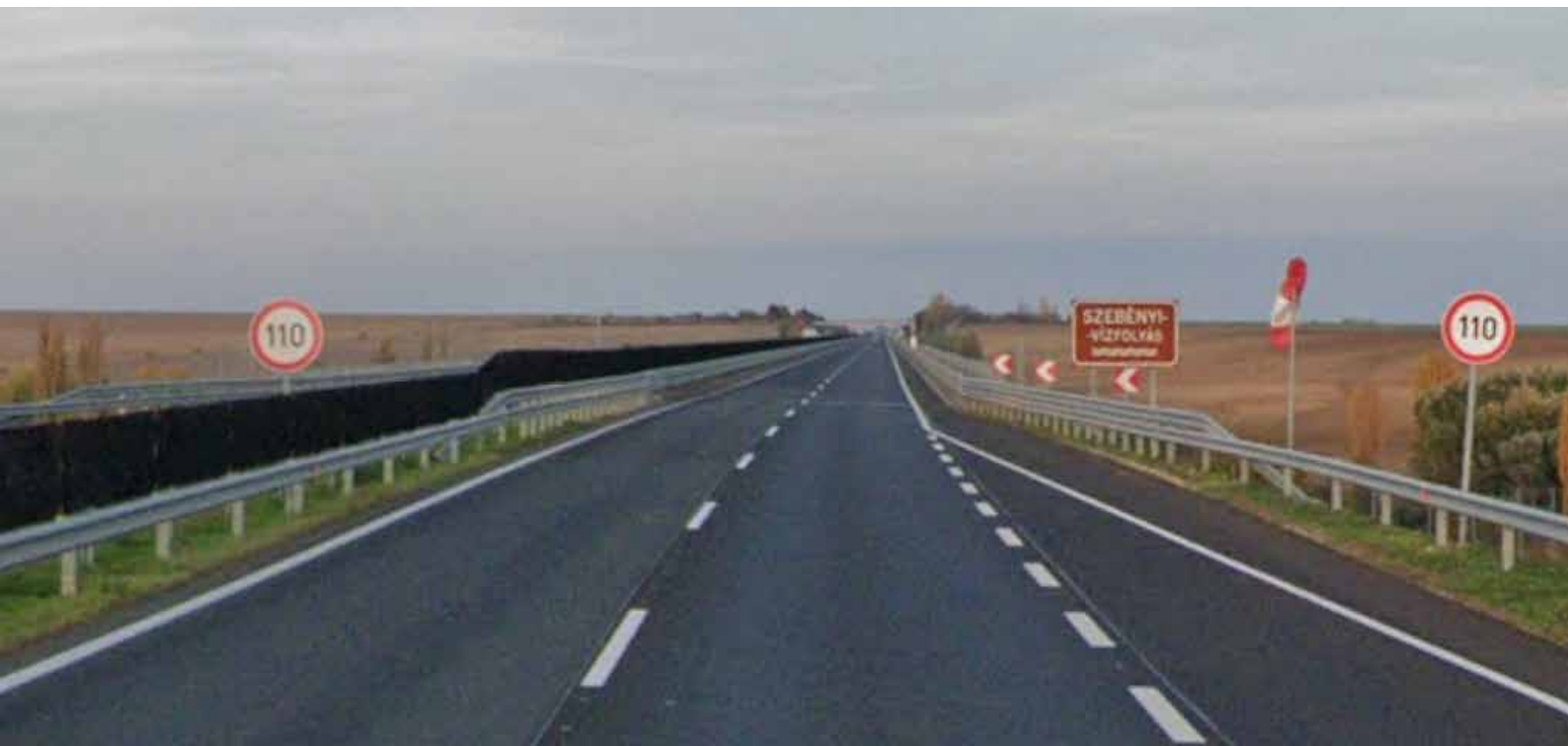
6. ábra: Szébenyi-vízfolyás völgyhíd bejáratí szakasza dél felől érkeve
